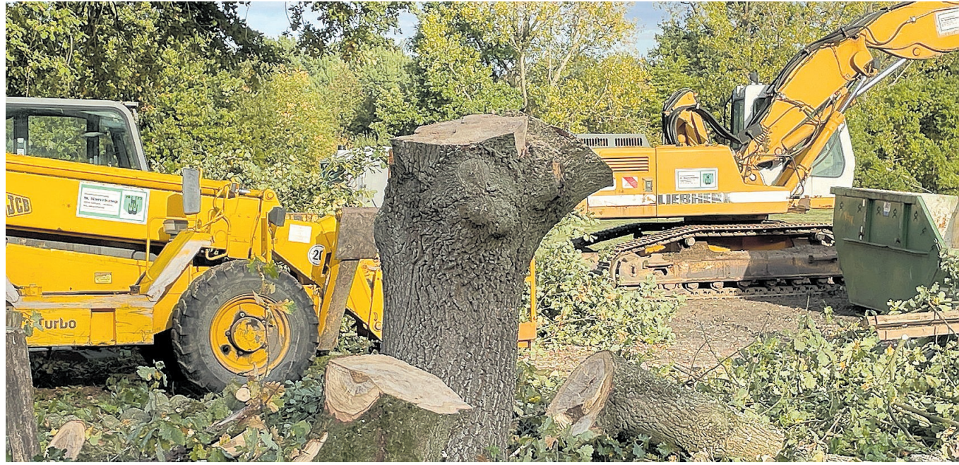
Eine von zwei alten Eichen wurde im neuen Baugebiet Zur Lehmkuhle gefällt. Anwohner fragen, ob das rechts war.
